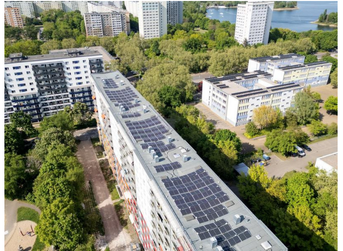
Lutbild - Photovoltaik, kurz PV-Anlage
