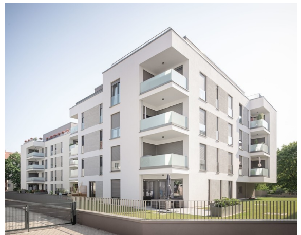
Außenansicht Wohnquartier Karl-Sasse
